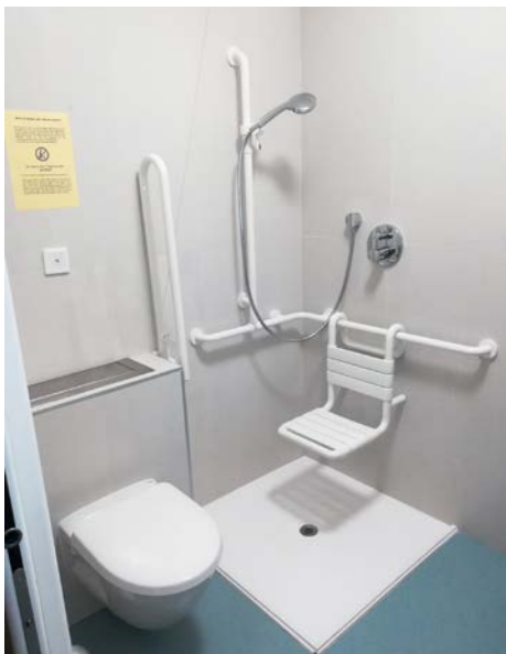
Servizio igienico in camera di degenza
